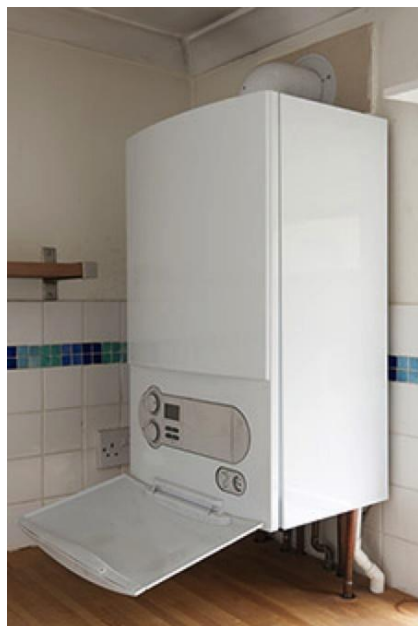
Chaudière gaz à condensation
